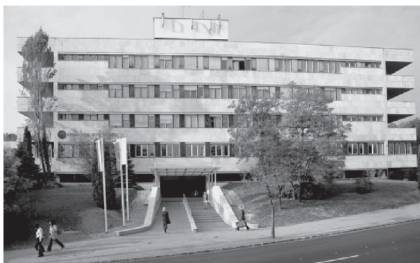
2. kép. A Pető Intézet Kútvolgyi úti épülete
